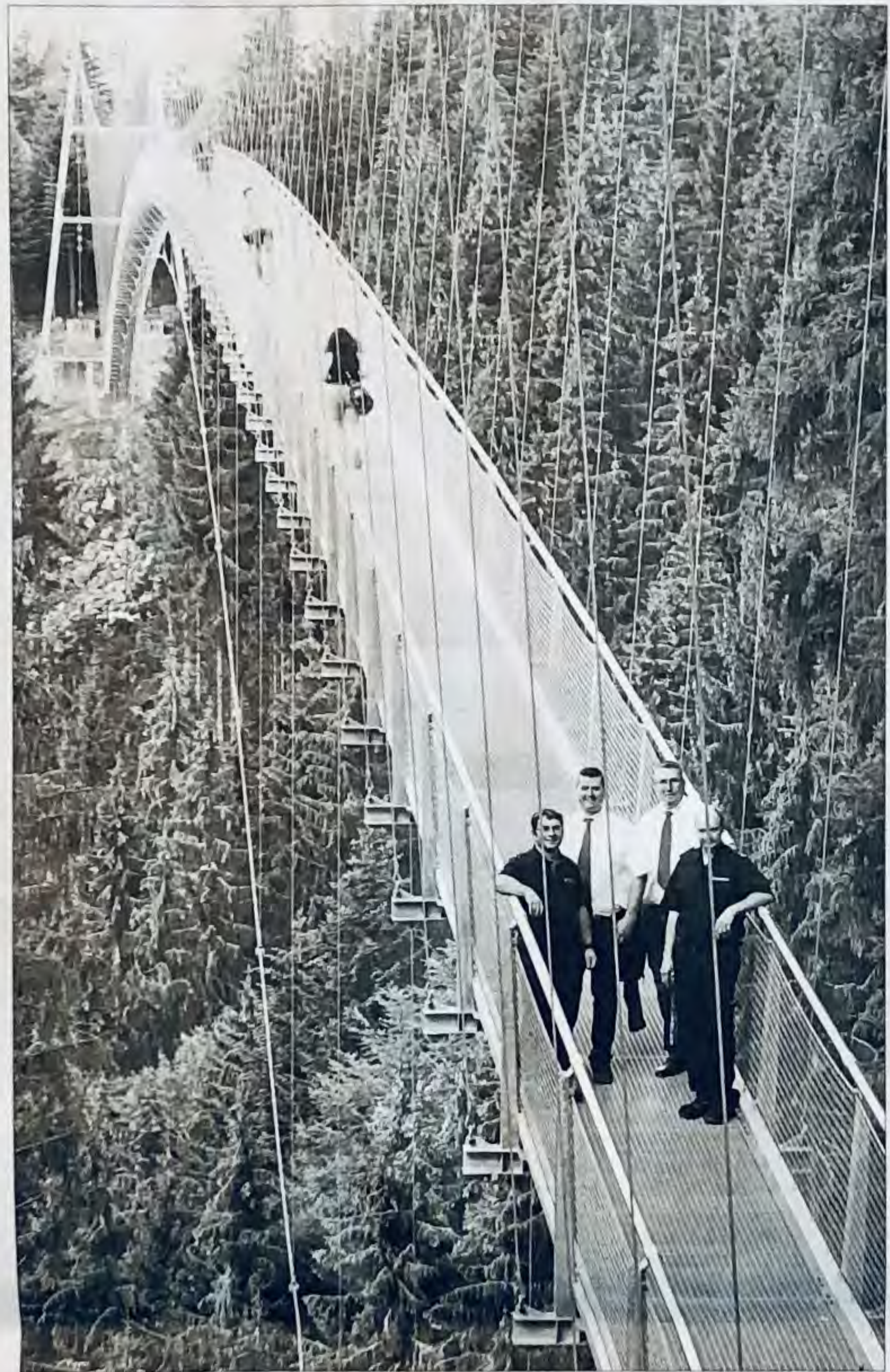
Die neue Hängebrücke auf dem Sommerberg erweitert das Aufgabengebiet der Rettungskräfte, in dem DRK und Feuerwehr zusammenarbeiten.
